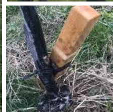
③支柱基部を杭で結束
